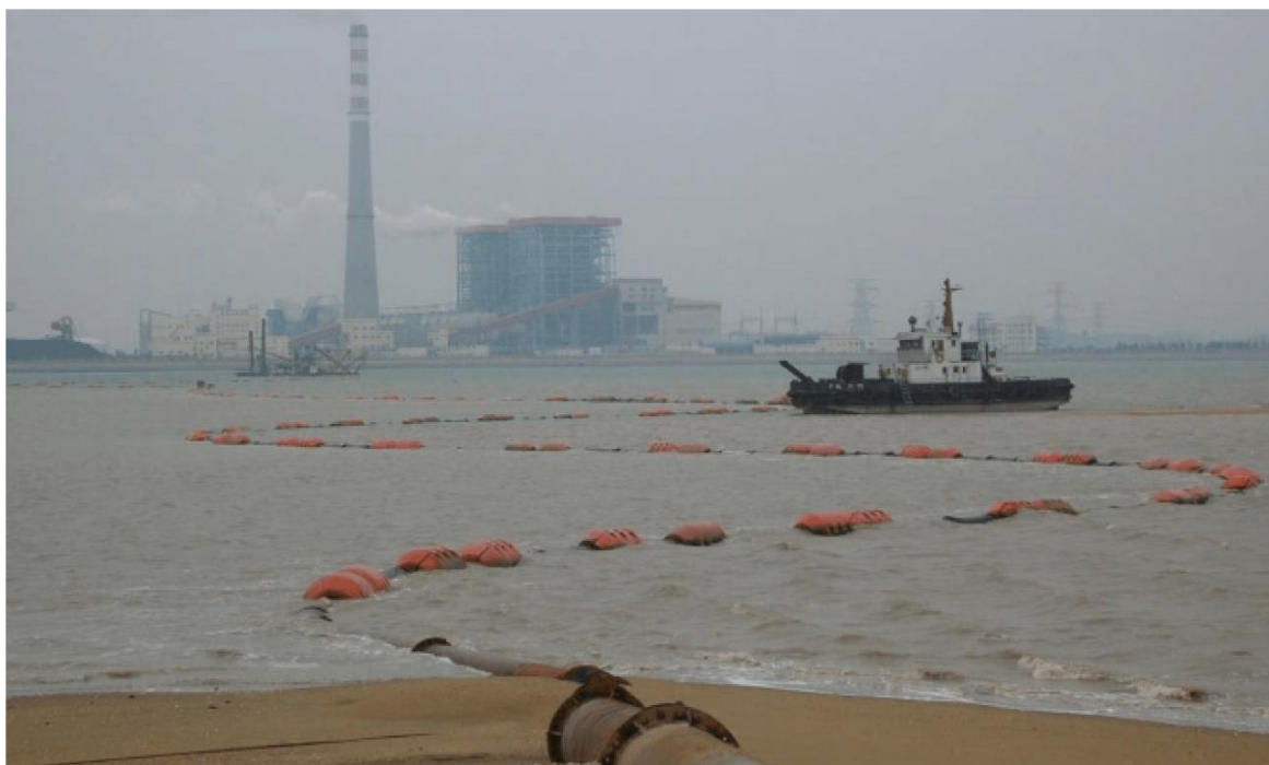
图 2.3.2-2 绞吸船输泥施工示意图
